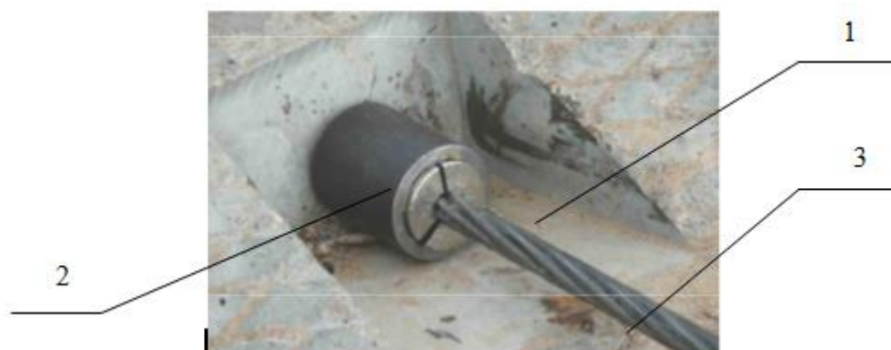
1 – крепежный карман, 2 – анкер, 3 – стальной канат
