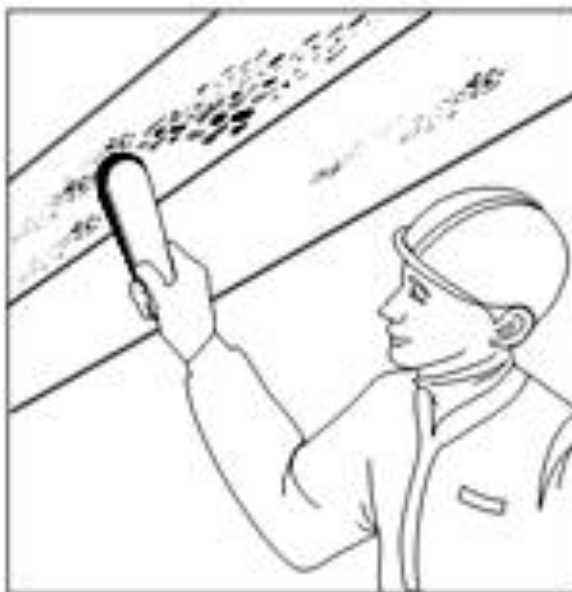
Рисунок 6.1. Очистка конструкции стальной щеткой металлической ручной.
