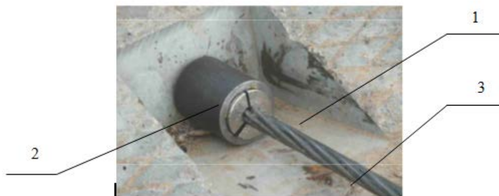
1 – крепежный карман, 2 – анкер, 3 – стальной канат
